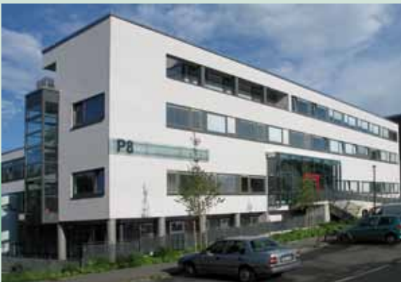
Das Gebäude für Optoelektronik, Integrierte Optik und Photonik beherbergt hoch-installierte Reinraum- und Laborflächen.
